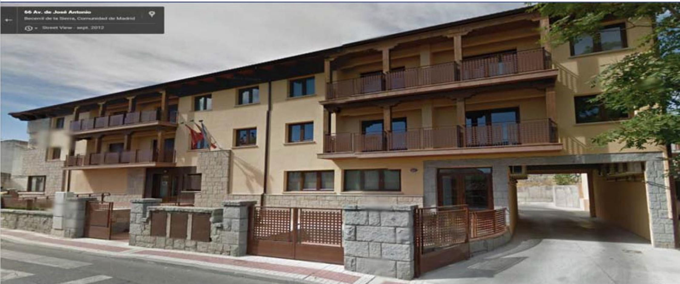
REHABILITACIÓN EDIFICIO MUNICIPAL EN BECERRIL DE LA SIERRA
